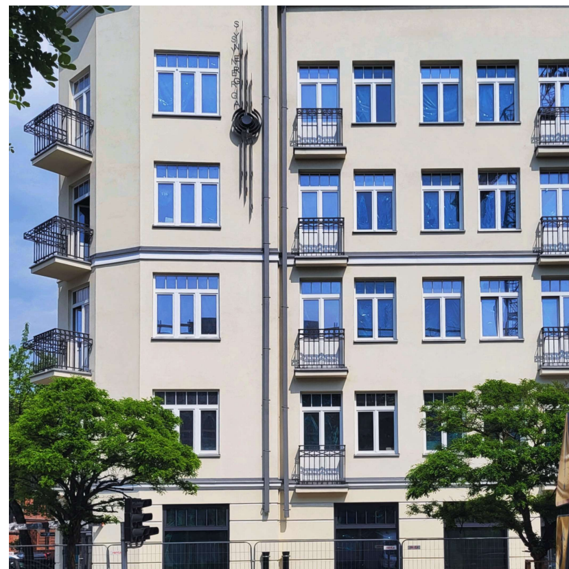
Kamienica po odtworzeniu, fot. m.st. Warszawa
