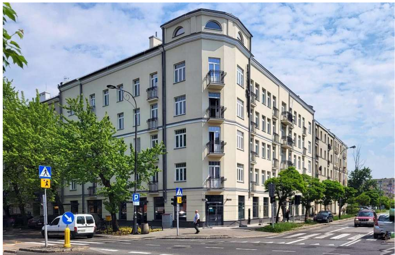
Kamienica po odtworzeniu, fot. m.st. Warszawa
