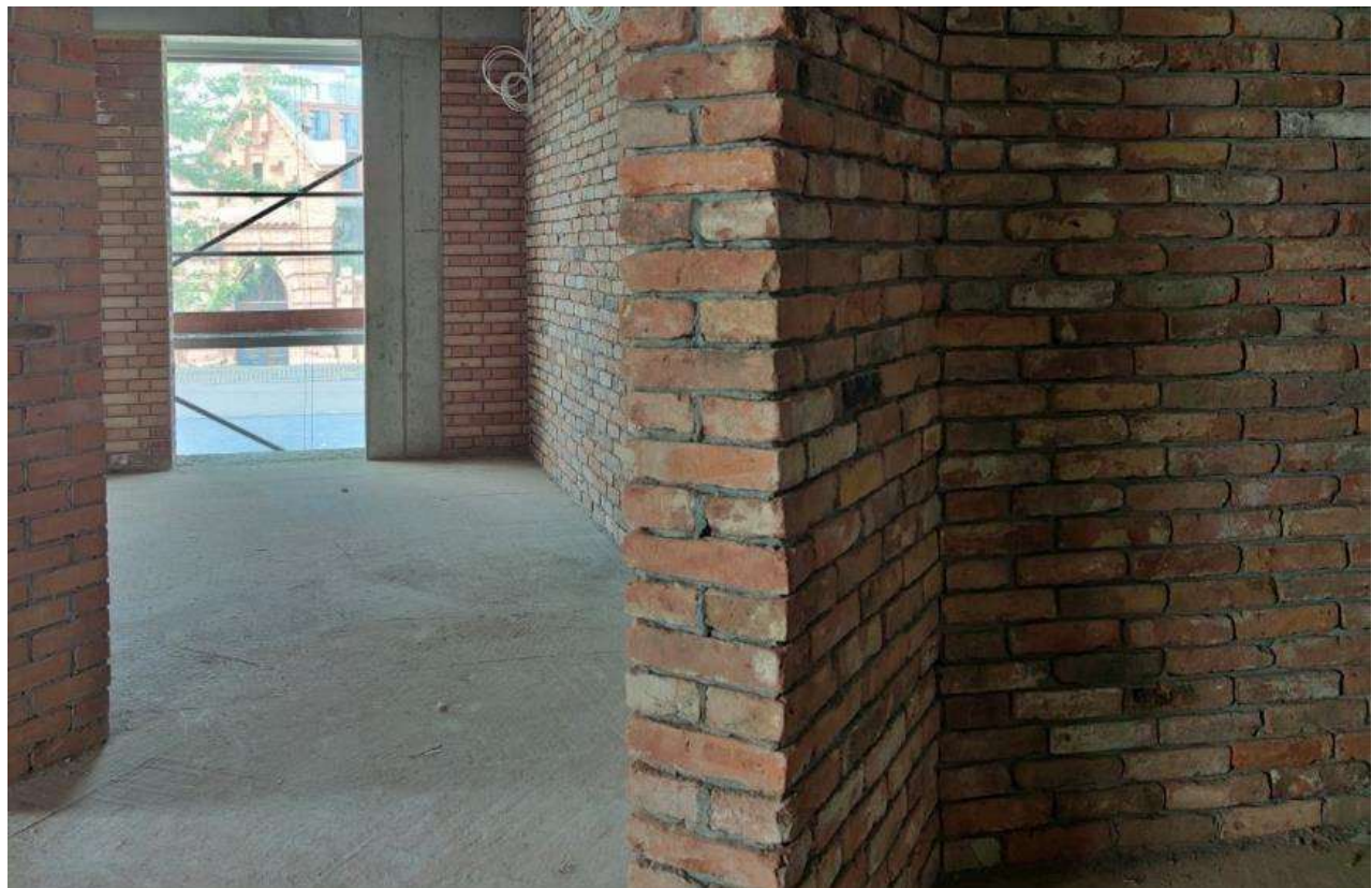
Wewnętrzna ściana kamienicy wykonana z zabytkowej cegły, fot. m.st. Warszawa
